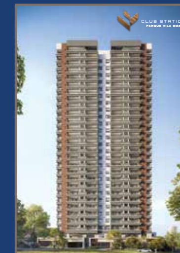
CLUB STATION PARQUE VILA EMA RUA DOMINGOS AFONSO, 741 X AV. VILA EMA, 1.411
