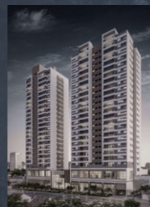
HIGH JD. PRUDÊNCIA RUA DAS FLECHAS, 484
